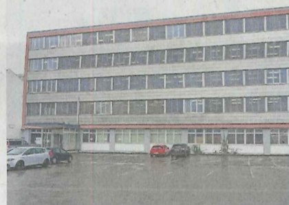
Das Schulprovisorium «Dreier» in der Oberentfelder Industrie überzeugt durch grossen, hellen Schulraum.
