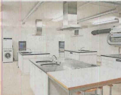
Die moderne Kücheneinrichtung konnte vom blauen Oberstufenschulhaus übernommen werden.
