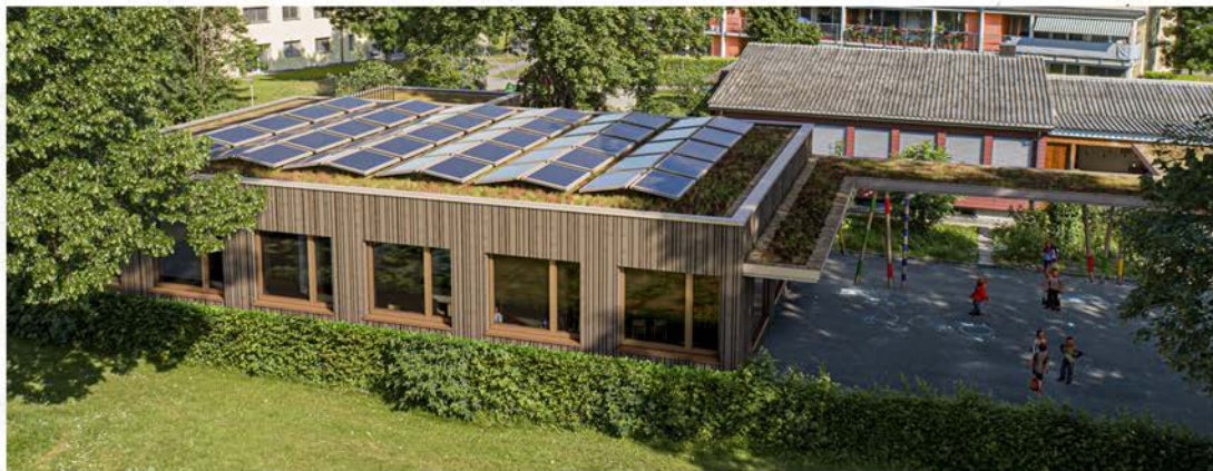
Der Kindergarten Triesch wird mit einem Erweiterungsbau um eine Abteilung ergänzt.
