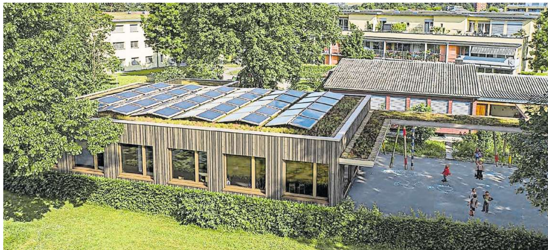
Der Kindergarten Triesch wird mit einem Erweiterungsbau um eine Abteilung ergänzt.
