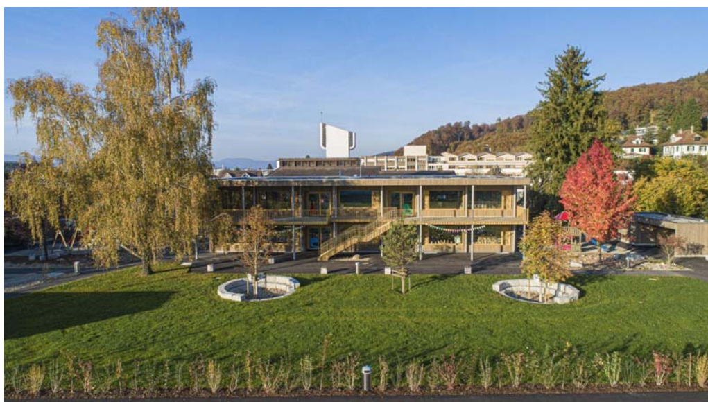
Die neugestaltete Umgebung des Kindergartens
