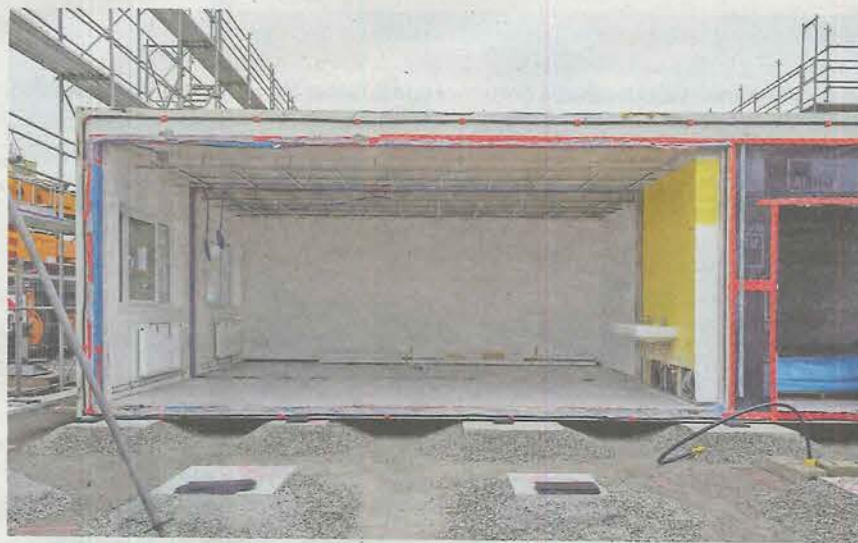
Die Pavillons werden auf Fundamenten aneinandergereiht.
