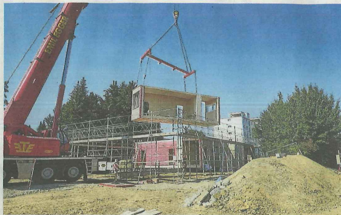
Vor zehn Tagen wurden die Elemente für den Kindergarten-Pavillon am Pappelweg geliefert und zusammengebaut. Bild: as zwöi gmbh/zvg
